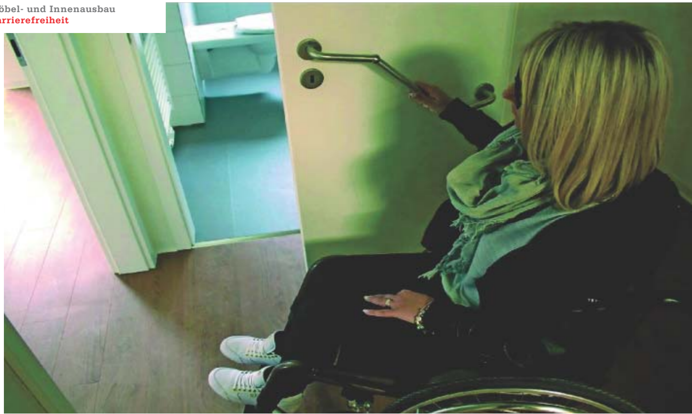
/ Komfortabel und barrierefrei: Die neuartige Sicherheitsfalttür mit durchdachter Drückergarnitur ermöglicht insbesondere Rollstuhlfahrern einen bequemen Bedienkomfort bei optimaler Ausnutzung des verfügbaren Raums.
