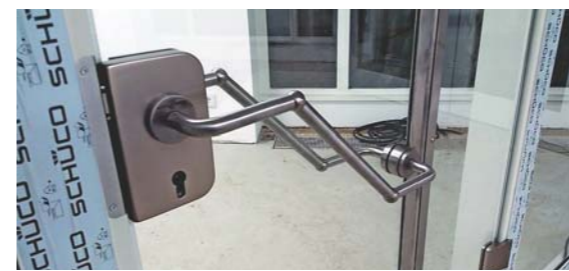
/ Der Drücker kann komfortabel von Rollstuhlfahrern sowie auch von nicht gehandicapten Menschen betätigt werden.
